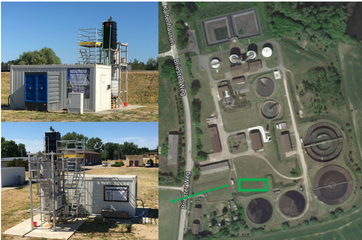
Abbildung 2.1: Luftbild der Kläranlage Brandenburg-Briest (Quelle: Google Maps, modifiziert)
