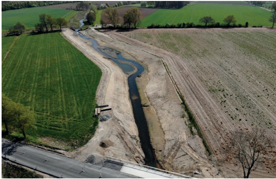
Rapphoffs Mühlenbach / fertiggestellter Bauabschnitt 2
