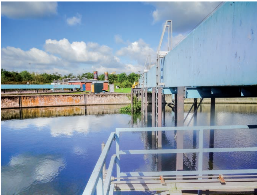
Räumbrücke Kläranlage Dortmund-Deusen
