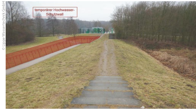
Bild 4: Temporärer Hochwasserschutzwall wasserseitig der HWE
